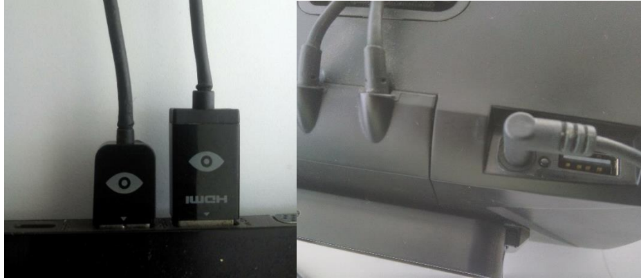
Gambar 1.13 Kabel Sudah Terpasang
